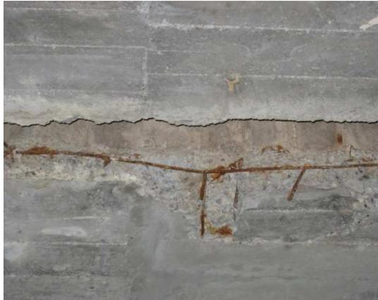
Sistemas de drenaje contruidos posteriormente, cortando las losas en pisos de los sótanos.
