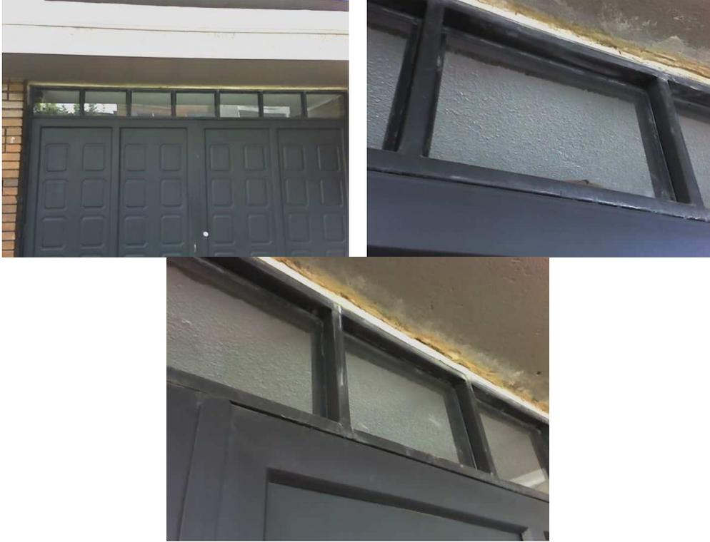
Se observan acabados defectuosos en la instalación de puerta exterior.
