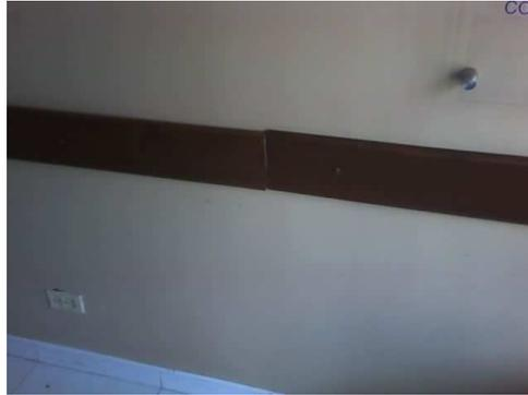
Se observa desprendimiento y desnivelación de los listones para espaldar de sillas.
