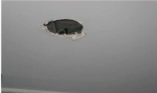
Perdida del recubrimiento en placa de entrepiso que evidencia el acero de refuerzo y dicha exposición ha afectado el refuerzo con corrosión del elemento estructural.
