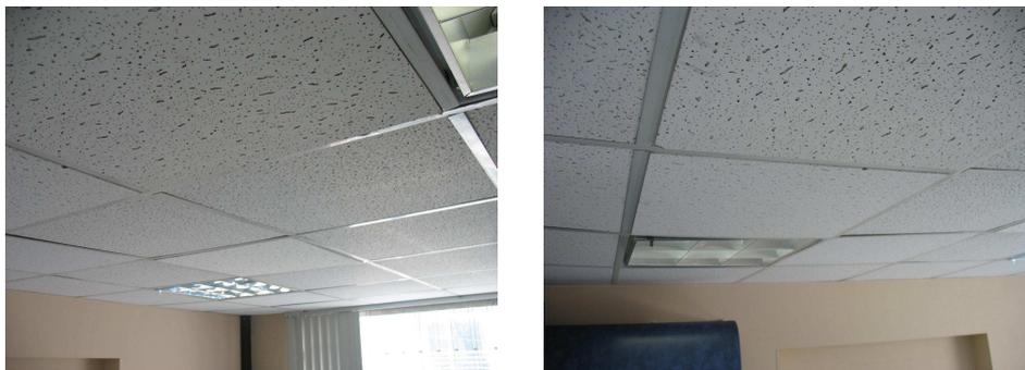
Se evidencia desnivelación y desprendimiento de las láminas del cielo raso.
