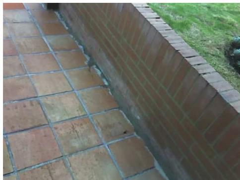
Se manifiestan grietas, fisuras y deficientes acabados en muro de ladrillo prensado.
